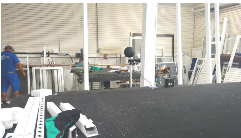
Figura 12 – Foto da montagem de esquadrias (Área 4)
