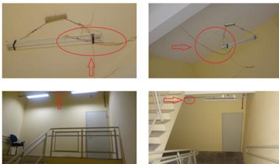
Figura 23 Fiação exposta e lâmpadas presas com fita adesiva
