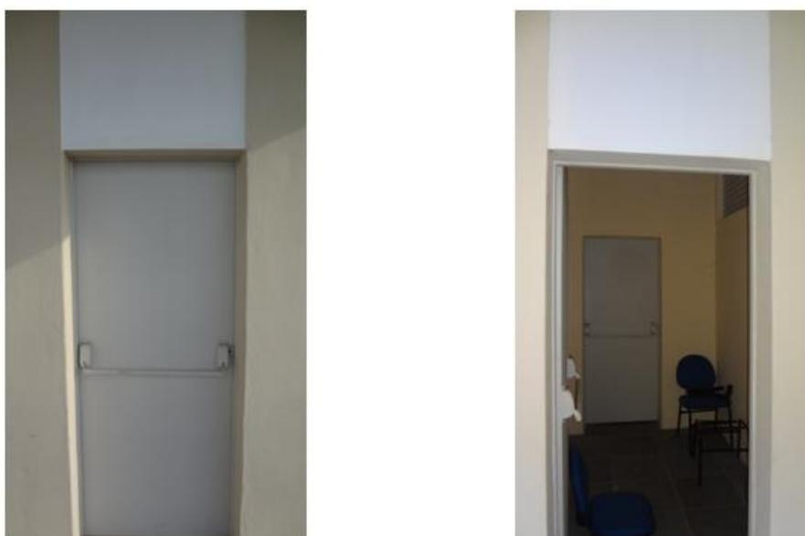
Figura 19 Portas da Saída de emergência do bloco “A” sem sinalização
