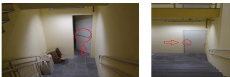
Figura 24 Portas com fechaduras estragadas
