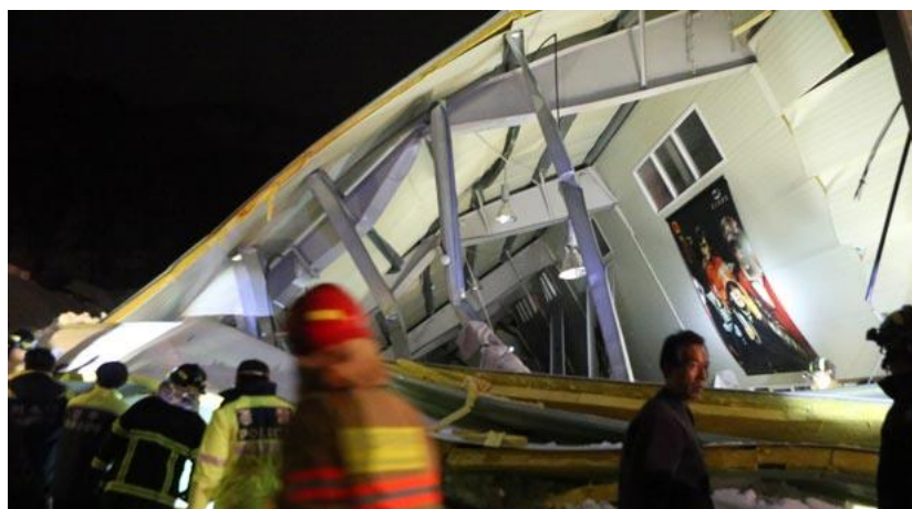
Figura 1 Desabamento de auditório na Coreia do Sul, 2014. Fonte: EM (2014)
