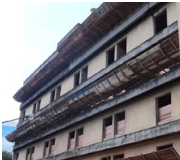
Figura 2 Plataforma de Retenção
