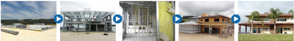
Figura 8 Etapas de obra utilizando o sistema LSF
