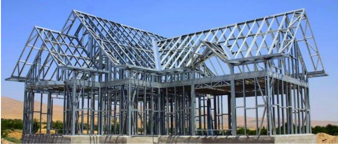
Figura 7 Esqueleto estrutural do sistema LSF
