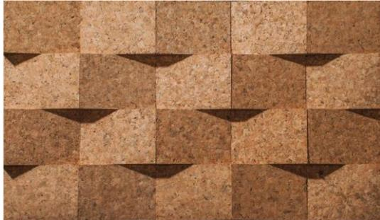
Figura 5 - Placas de cortiça usadas como revestimento interno com a intenção de melhorar a eficiência térmica;
