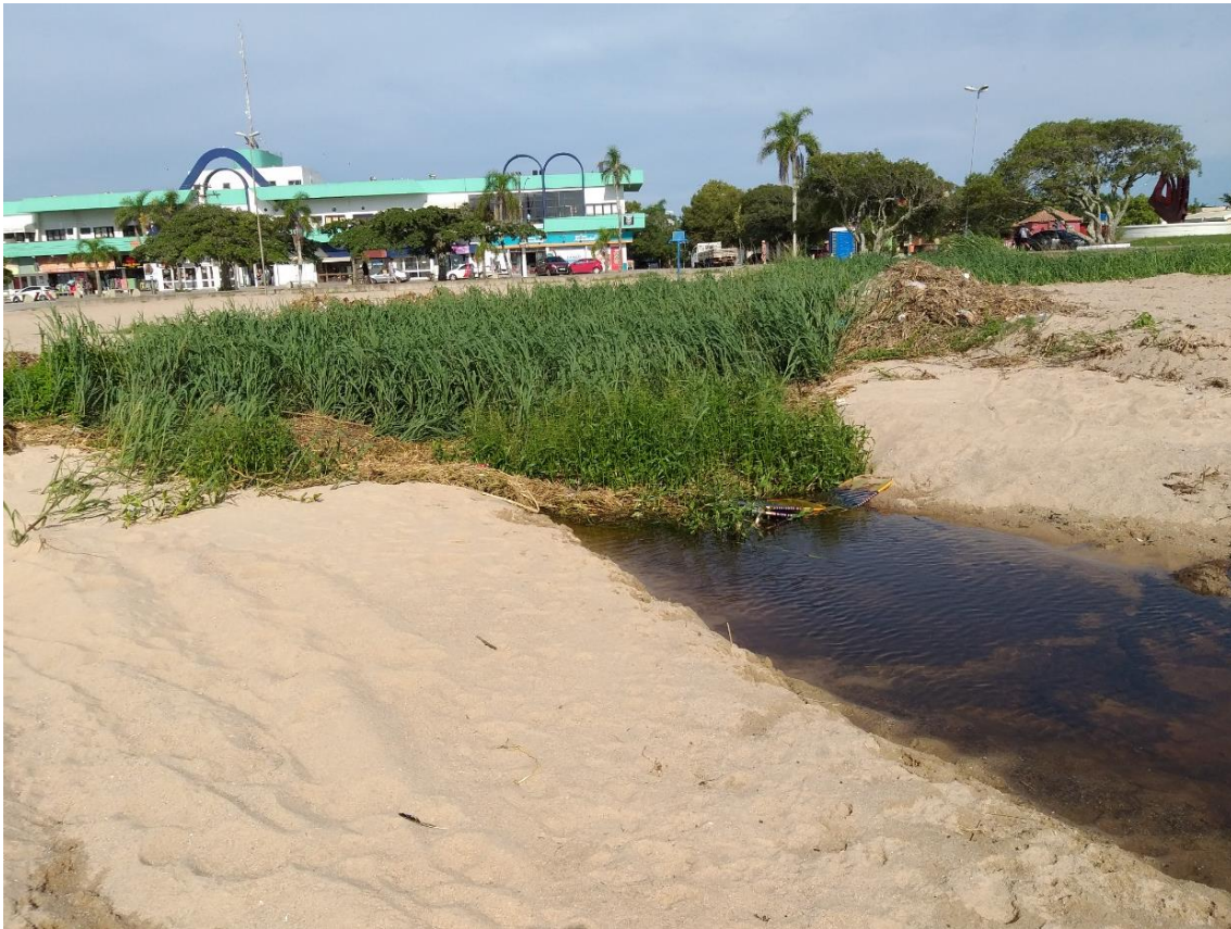
Figura 41: Sistema de drenagem de águas pluviais (Fonte: Autora, 2019).
