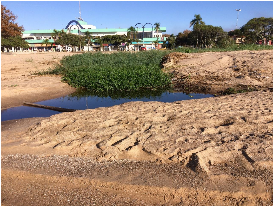
Figura 17:Comporta de escoamento de águas pluviais próxima ao Ponto 1 (Rua Tuparendi) (Fonte:Autora,2019).
