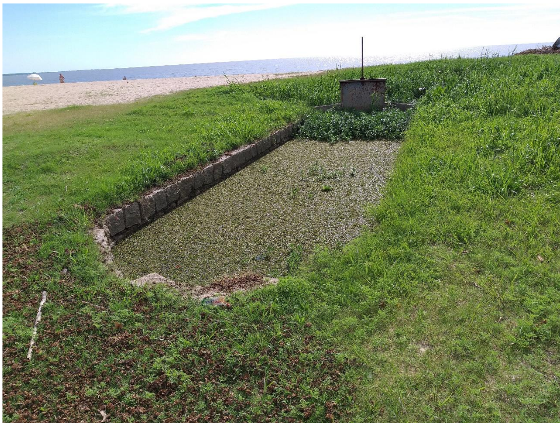
Figura 42:Comporta situada próximo à Rua Tuparendi (Fonte:Autora,2019).
