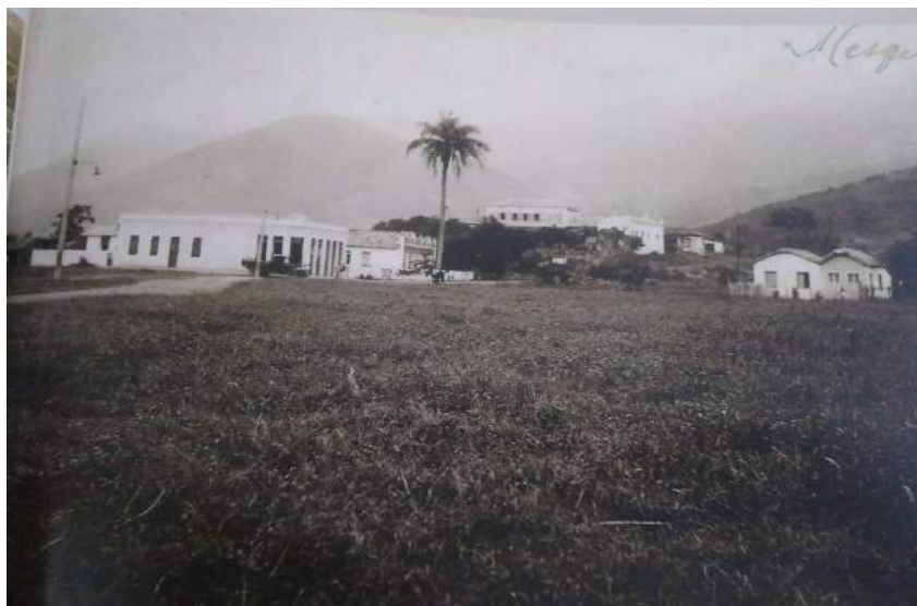
Figura 29: Casa sede da Fazenda Cachoeira ao fundo e a capela de Nossa Senhora da Conceição. Fonte: Exposição da Casa de Cultura Ney Alberto - Nova Iguaçu.
