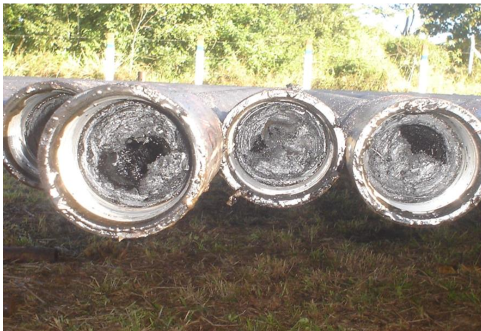
Figura 2- Deposição das parafinas em dutos de petróleo
