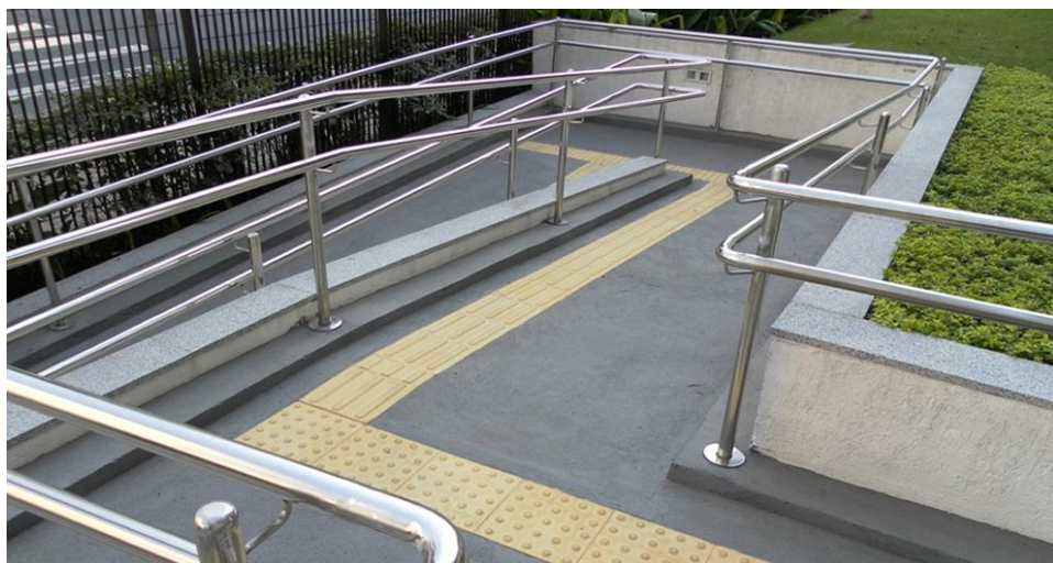
Figura 3-Rampas adequadas às normas de acessibilidade
