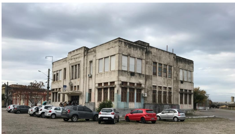
Figura 6-Prédio da Alfândega em 2018
