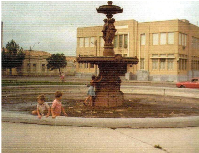
Figura 5-Prédio da Alfândega em 1977
