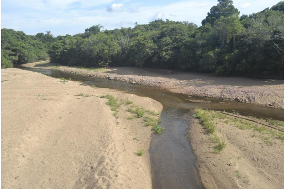
Figura 22. Trecho assoreado sob a Ponte Maria Gomes, no município de Arambaré, RS
