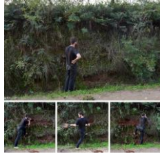
Figura 09: Coma ..... 42 processo de escavação
